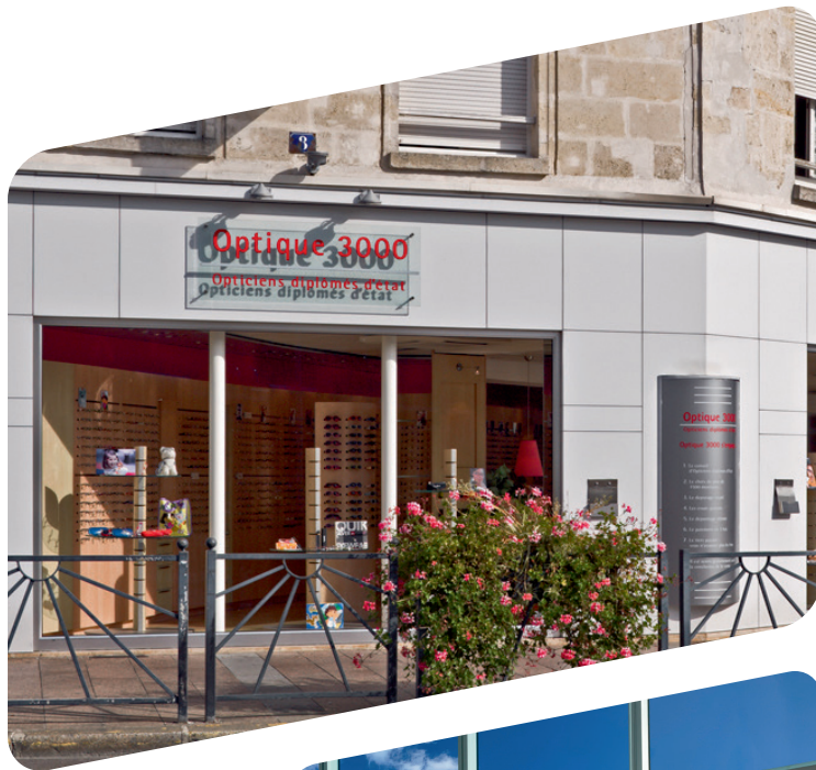
Shopfront glazing Optique 3000, Crépy-en-Valois
